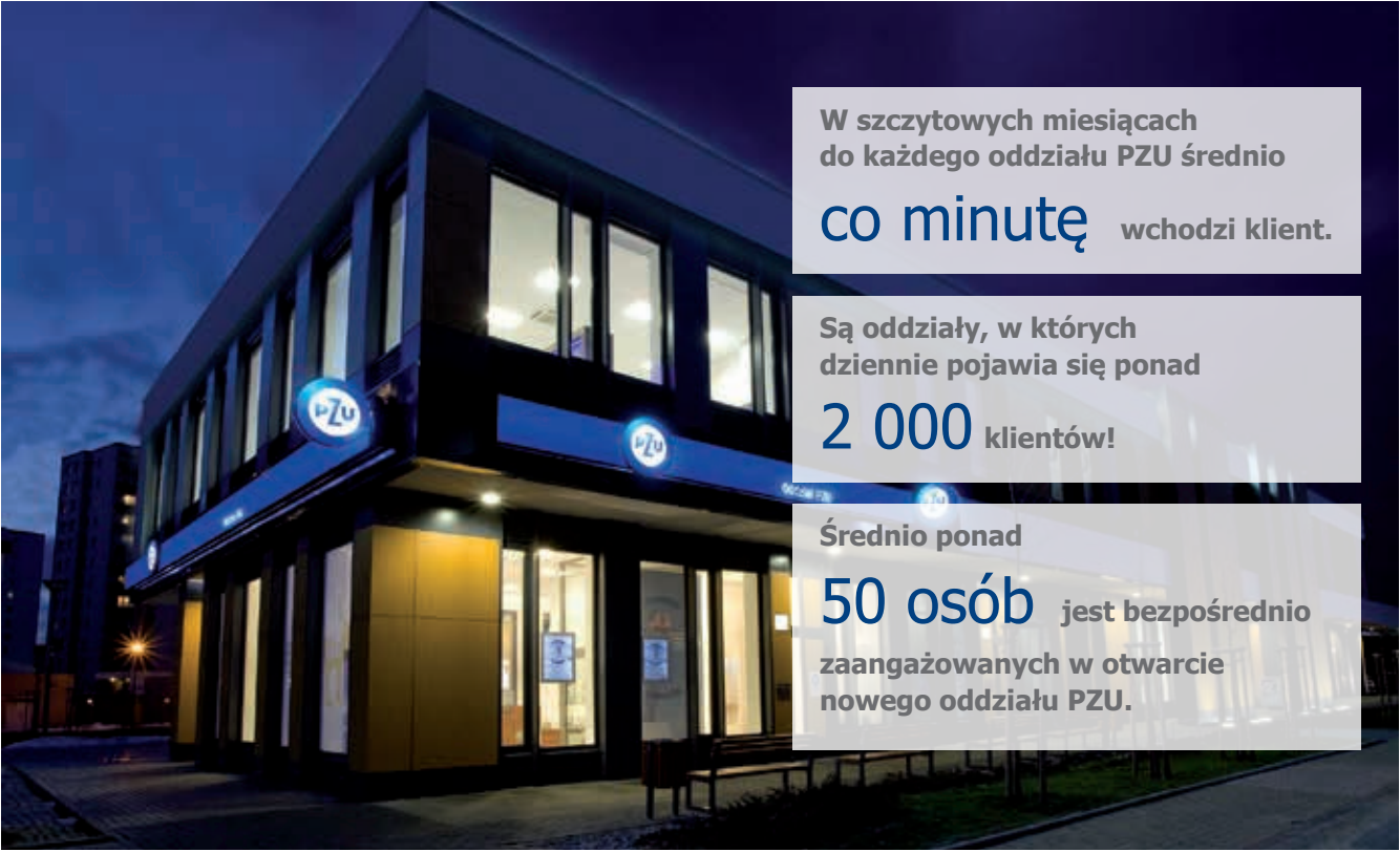
Fot. Oddział PZU we Wrocławiu po rewitalizacji
